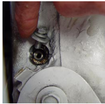
Photo ABO-7: Motor Brace bolt.
